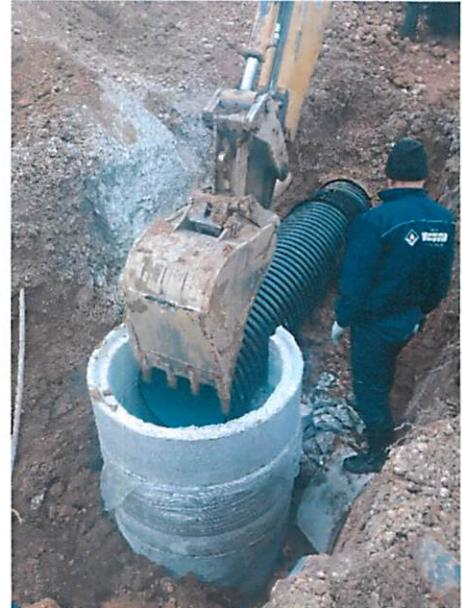
*Skica br. 5. Situacija -izvedeno stanje -izgrađeni kišni kolektor u naselju Dolovi II i slike radova na izgradnji kišnog kolektora*
