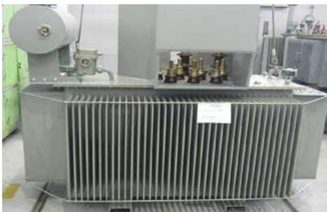
Slika br 4. Izgled transformatora 10/0,4 kV, 630 kVA
