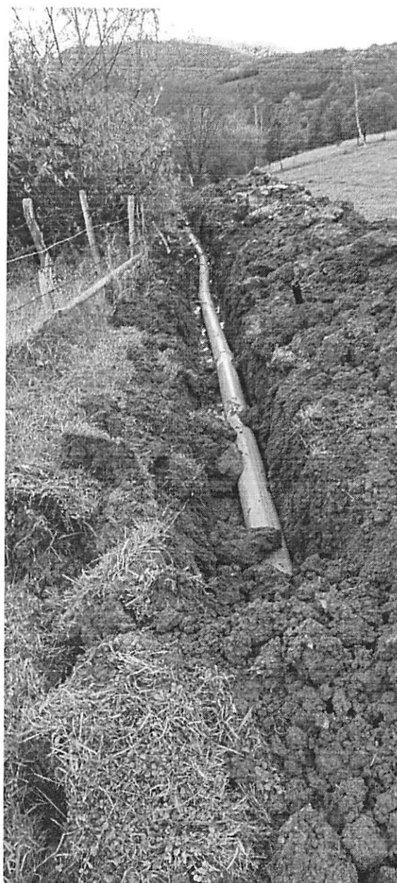
Slika br.1. Izgradnja fekalne kanalizacije u naselju Deveta
