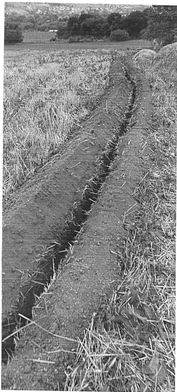
Slika br. 9. Radovi na izradi vodovodnog priključka u Gornjim Kominima
