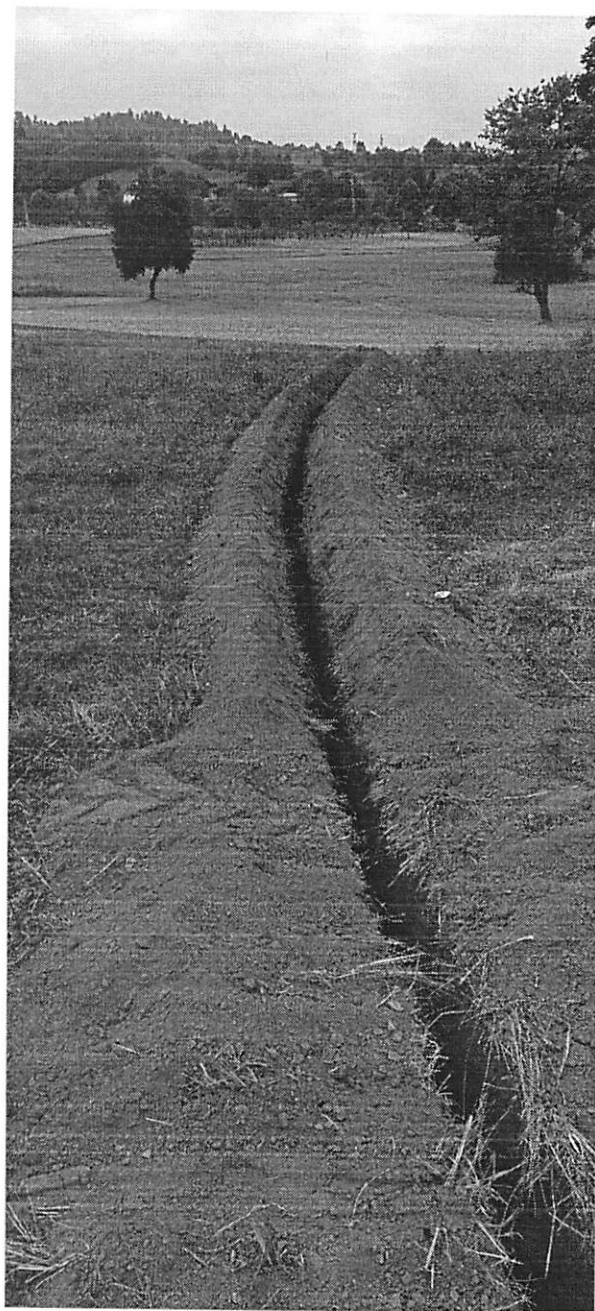
Slika br. 9. Radovi na izradi vodovodnog priključka u Gornjim Kominima
