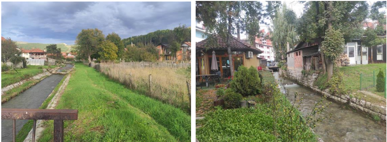
Slika 9 i 10. Pogled na trasu toplovoda (plava linija), desna obala Breznice.
