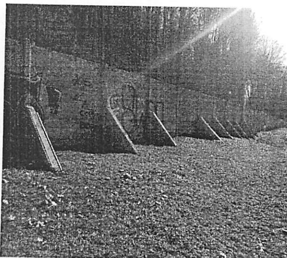
Slika 16: Postavljeni potporni zidovi na istočnoj strani
