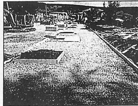
Slika 22,23: Montaža ivičnjaka oko 52 stabla drvoreda u ul. V.Jakić uključujući iskop sadne jame i postavljanje eko platna unutar sadne jame
