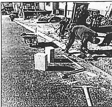
Slika 19,20,21: Postavljanje uličnih ivičnjaka u ul. III sandžacke u dužini od 10m, ul.B.Jovanovića u dužini od 15m sa postavljanjem behaton ploča 40m kv., ul.Podgorička u dužini od 20m.
