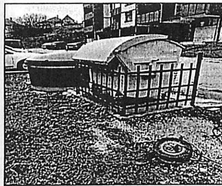
Slika 26,27,28: Izrada betonskih podesta sa ivičnjacima i potpornim zidom za kontejnere u ul. Deveta, ul. Đurđevdanska, ul. Ostroška, ul. P.Leovca i ul. Hamdije Šahimpašića
