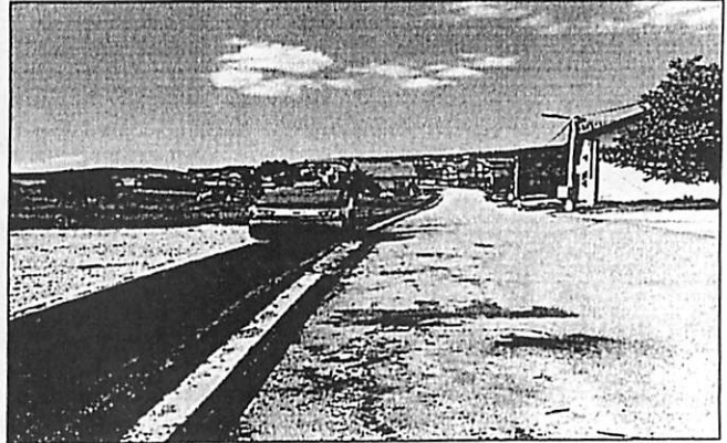
Slika 17,18: Priprema za asfaltiranje (nasipanjem i valjanjem tamponske podloge) trotoara u ul.Rudarskoj, RVI
