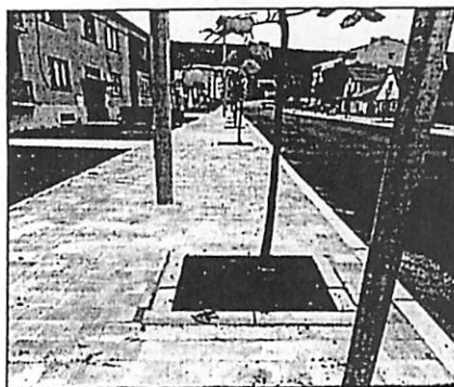
Slika 22,23: Montaža ivičnjaka oko 52 stabla drvoreda u ul. V.Jakić uključujući iskop sadne jame i postavljanje eko platna unutar sadne jame
