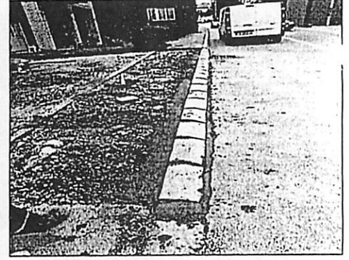
Slika 19,20,21: Postavljanje uličnih ivičnjaka u ul. III sandžacke u dužini od 10m, ul.B.Jovanovića u dužini od 15m sa postavljanjem behaton ploča 40m kv., ul.Podgorička u dužini od 20m.
