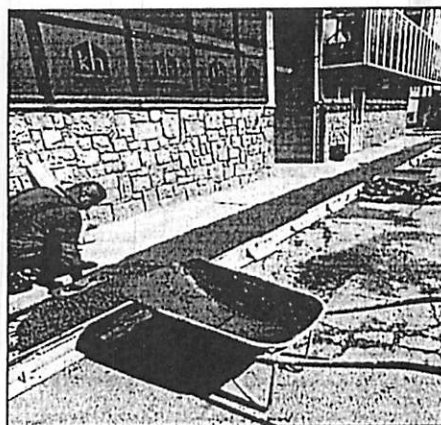
Slika 25: Izrada betonskog cokla na parkingu „Expres u dužini od 20m
