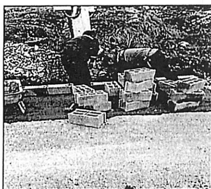
Slika 26,27,28: Izrada betonskih podesta sa ivičnjacima i potpornim zidom za kontejnere u ul. Deveta, ul. Đurđevdanska, ul. Ostroška, ul. P.Leovca i ul. Hamdije Šahimpašića
