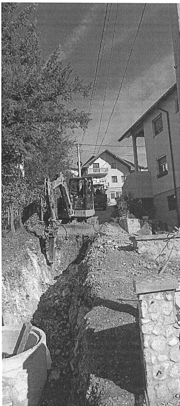
Slika br.3. Radovi na izgradnji kišnog kolektora – ulica Zetska
