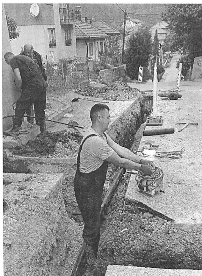
Slika br.3. Rekonstrukcija vodovodne mreže na raskrsnici ulica „Velimira Jakića“ i ulice „20. Novembra“
