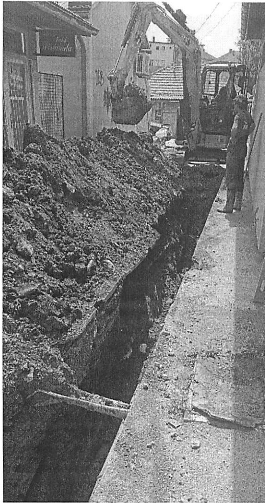
Slika br.1. Izgradnja fekalne kanalizacije ulici Sutjeska
