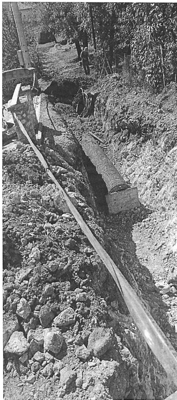
Slika br.3. Radovi na izgradnji kišnog kolektora – ulica Zetska
