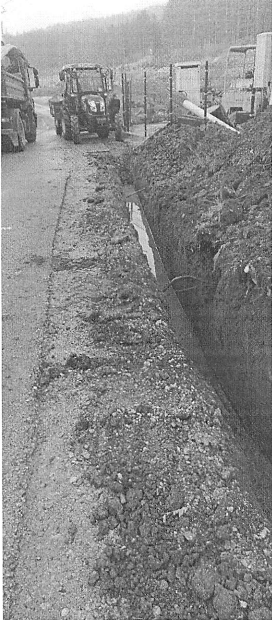
Slika br. 9. Rekonstrukcija vodovodne mreže u naselju Deveta
