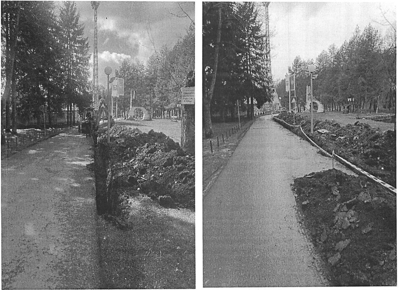
Slika br.2. Rekonstrukcija hidroinfrastrukture u parku Vodice
