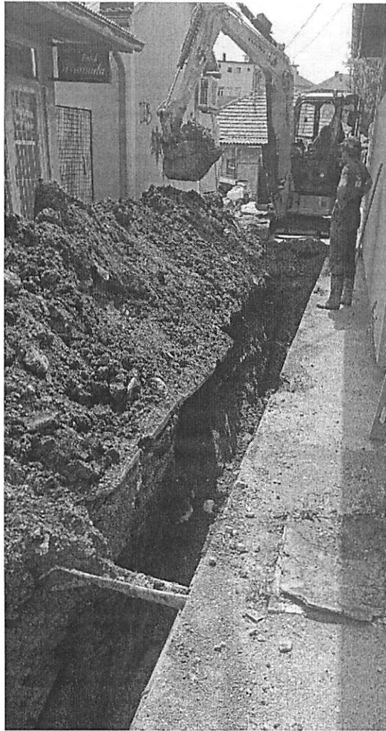
Slika br.1. Izgradnja fekalne kanalizacije ulici Sutjeska
