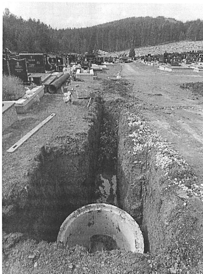
Slika br.4. Radovi na izgradnji drenažne kanalizacije na gradskom groblju Ravni
