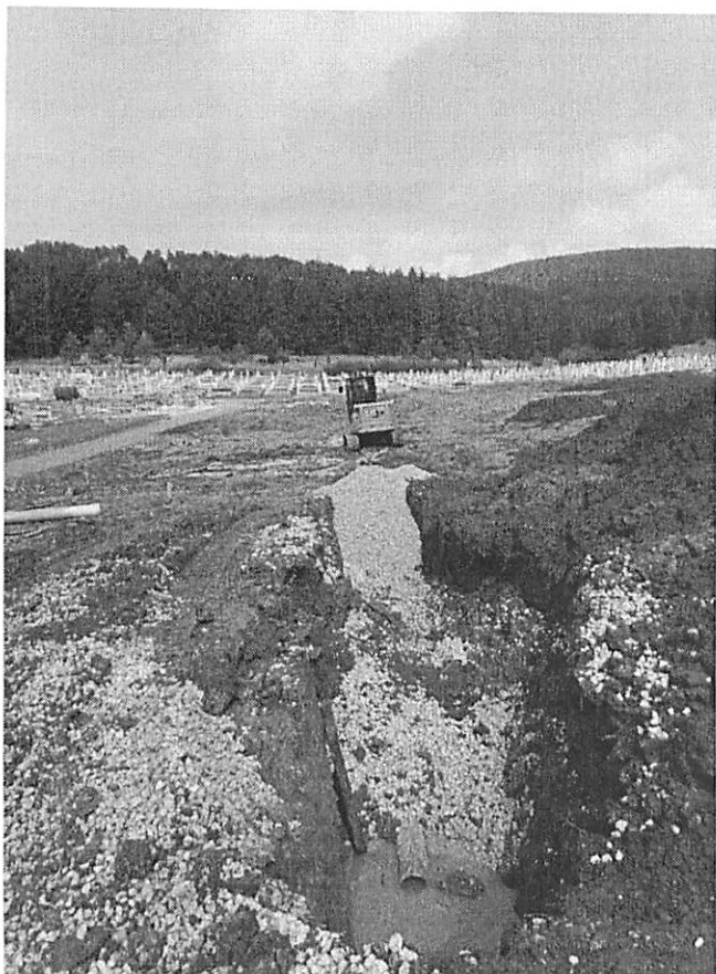
Slika br.4. Radovi na izgradnji drenažne kanalizacije na gradskom groblju Ravni
