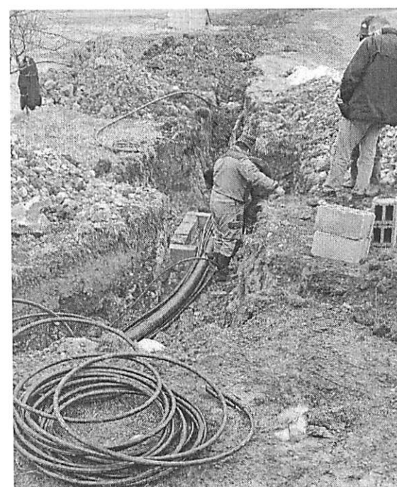
Slika br.1. Radovi na izgradnji primarnog cjevovoda „Troje česme“
